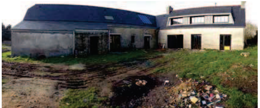
Une vingtaine d'ouvertures en alu et une verrière ont été installées.
