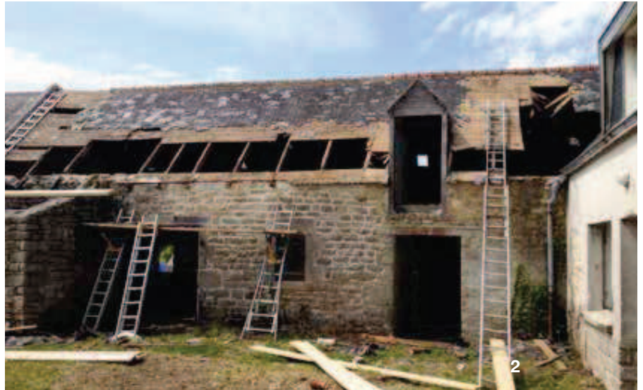
C'est Frédéric Geay qui s'est occupé de la démolition.
