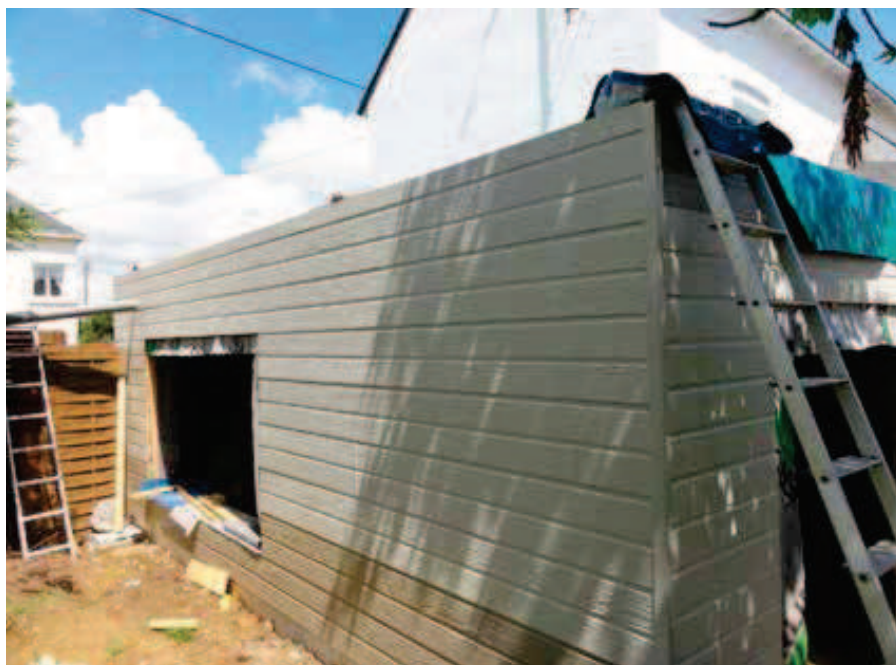
Une extension de 22 m 2 a agrandi la surface habitable de 50%.
