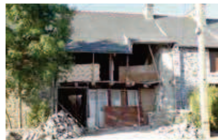
Dernière étape du chantier en 2006 : le démontage et remontage de la façade en pierres d'un des bâtiments.
